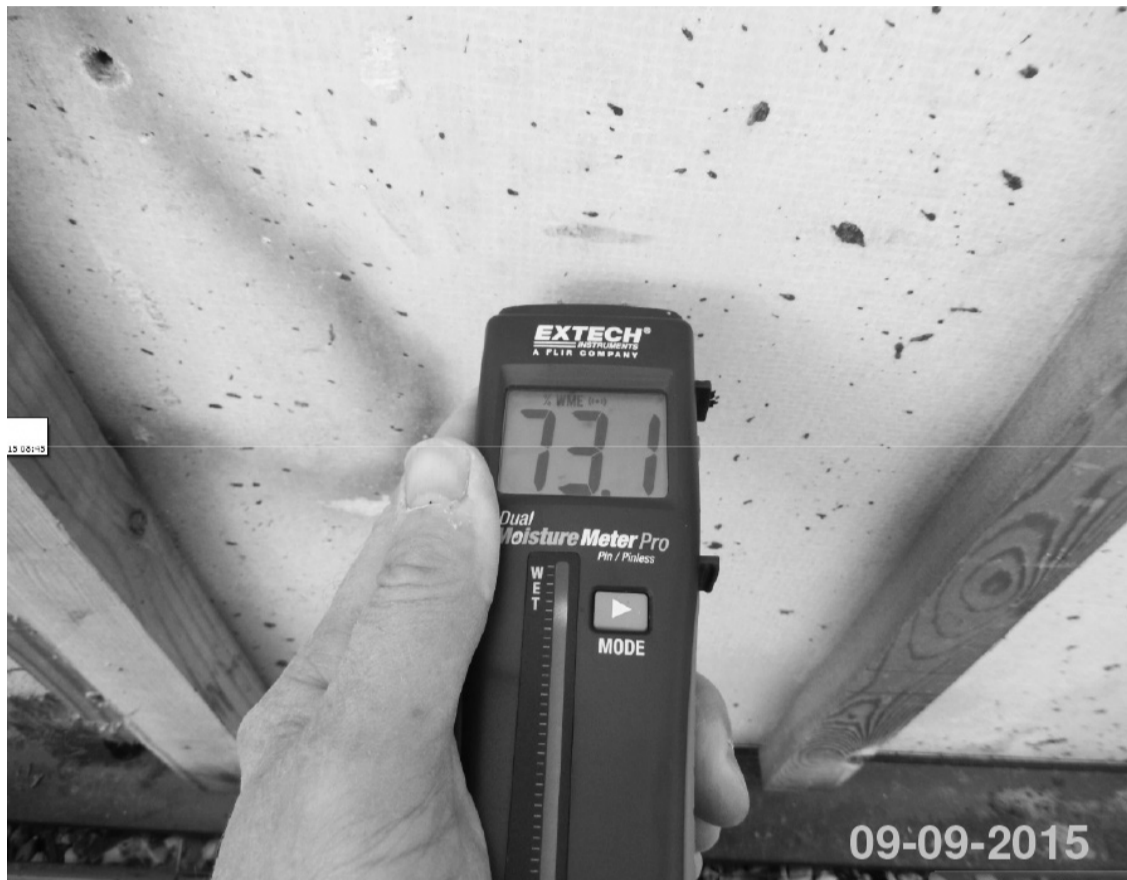
Vindspærre under vindue er kraftigt opfugtet. 73,1%
